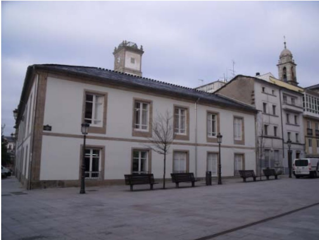
Estado actual. Exterior lateral Concello y fachadas Anxo Fernández 4 y 2
