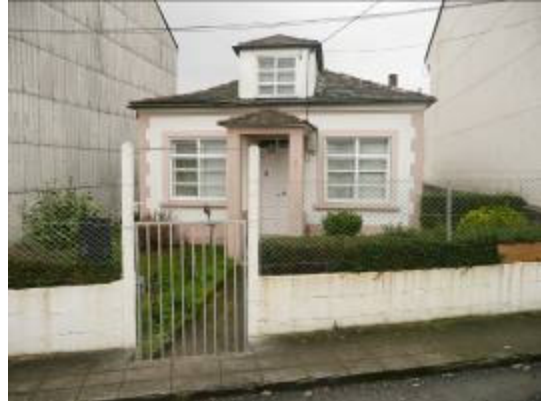
Pk: 0+050. Edificación exenta existente.
