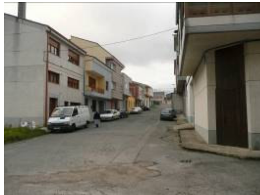
Pk: 0+300. Rúa Monte Pico Sacro Vista en dirección Calzada das Gándaras
