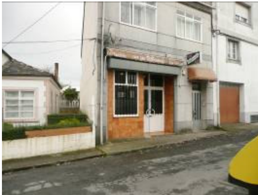
Pk: 0+050. Cafetería existente
