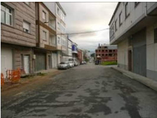
Pk: 0+325. Fuera del ámbito de proyecto. Ubicación de Pozo nº 2887 de conexión con red Unitaria Vista en dirección Venancio Senra.
