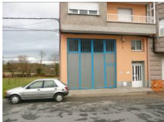
Pk: 0+325. Fuera del ámbito de proyecto Vista en dirección Sureste. Límite de suelo Urbano
