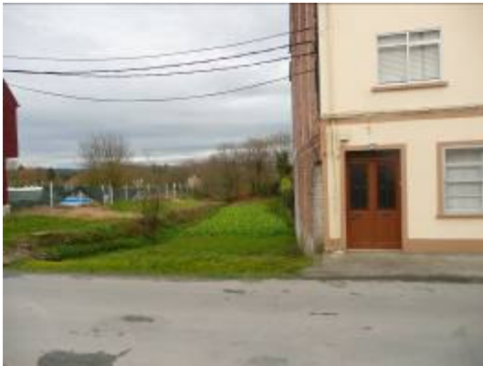
Pk: 0+235. Portales más bajos de la calle . Nº54 Ubicación Pozo R4. Punto más bajo de la calle. Vista en dirección Sureste.
