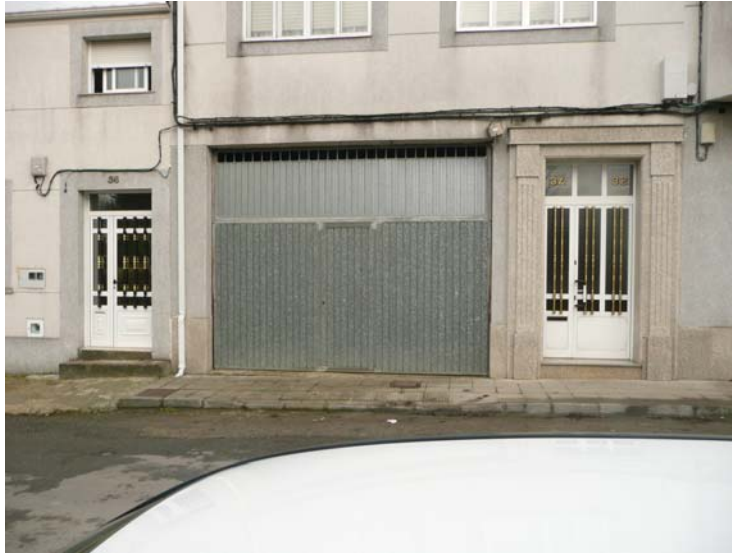
Imagen nº2 Alturas muy variables de acceso a las edificaciones.
