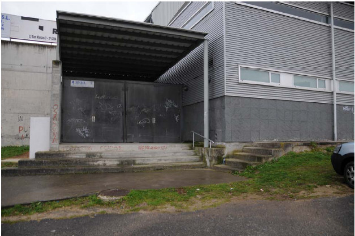
Estadio Acceso al graderío Noreste
