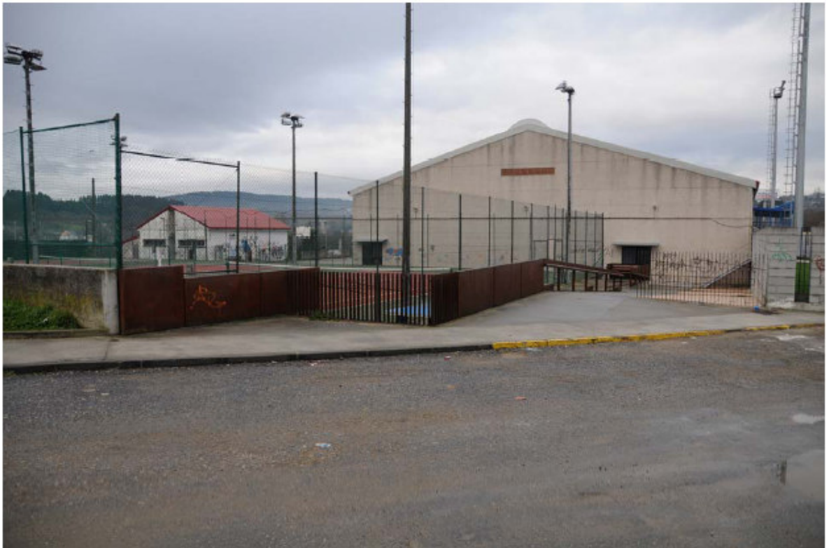
Complejo "O Palomar". Detalle de acceso desde calle Noroeste.
