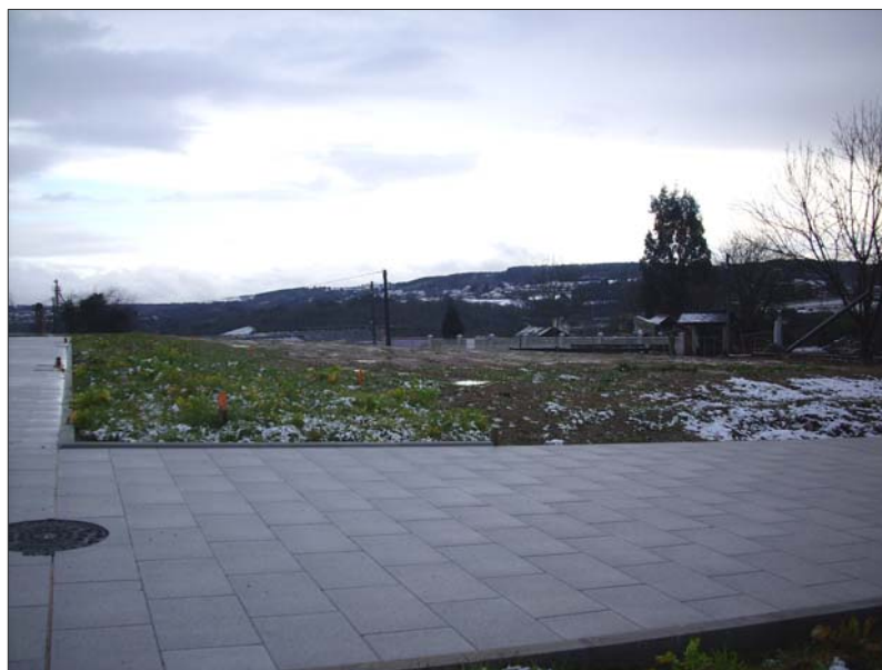
Fotografía 2: vista parcial del solar.
