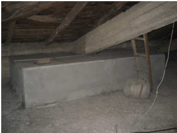
CUBIERTA DE ASCENSORES
