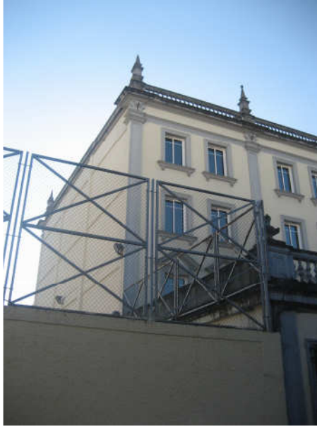
ESQUINA ESTE DE FACHADA
