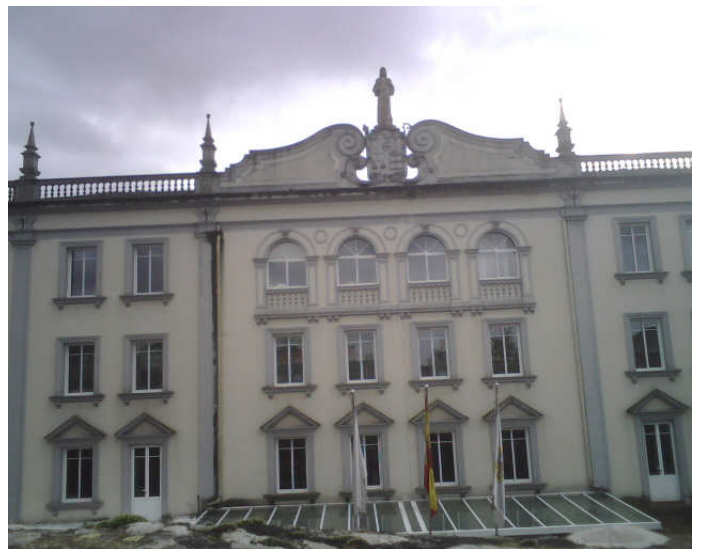
PARTE CENTRAL FACHADA NORTE
