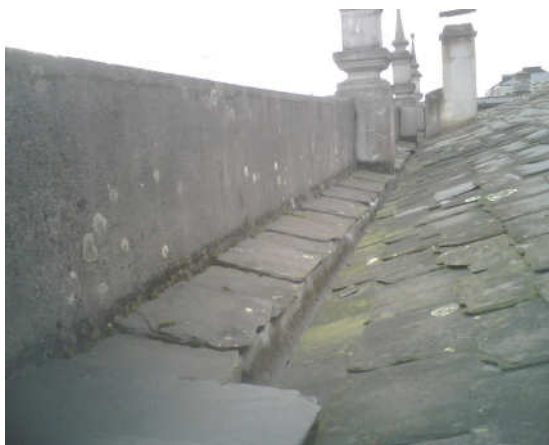
CANALÓN DE CUBIERTA
