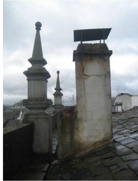
CHIMENEA DE CUBIERTA
