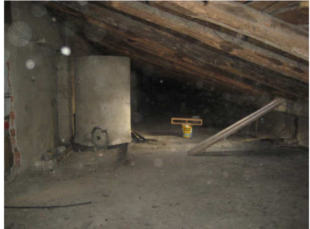
INTERIOR FALDÓN SUR
