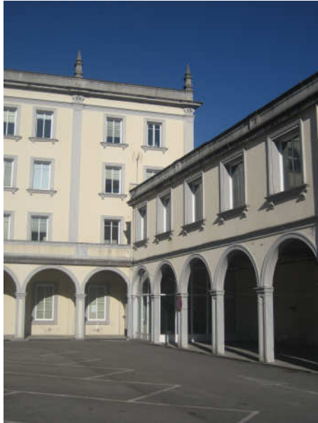
ENCUENTRO ENTRE EDIFICIO CENTRAL Y PABELLÓN ESTE
