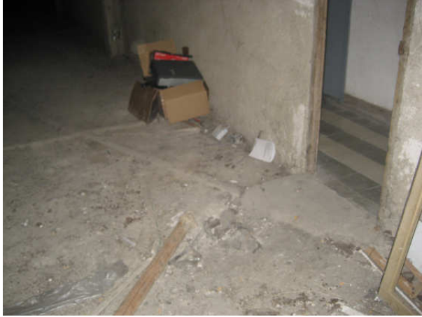
ACCESO A BAJOCUBIERTA DESDE PASILLO
