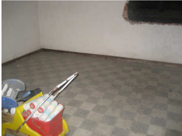
PAVIMENTO DE SALA EN BAJOCUBIERTA
