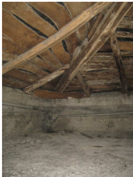
INTERIOR DE LIMA CUBIERTA OESTE-SUR
