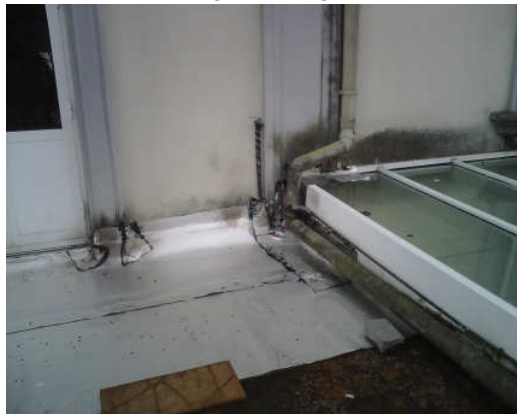
IMPERMEABILIZACIÓN DE TERRAZA
