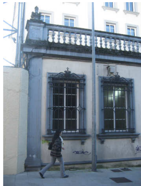
DETALLE ESQUINA OESTE
