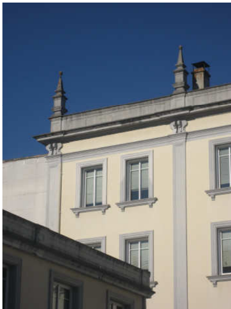
DETALLE DE ESQUINA OESTE FACHADA SUR
