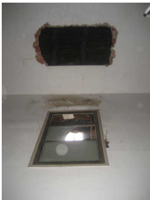
DETALLE DE HUECO EN FALSO TECHO DE SALAS
