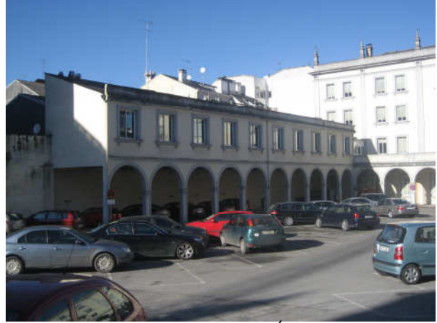
VISTA GENERAL PABELLÓN OESTE
