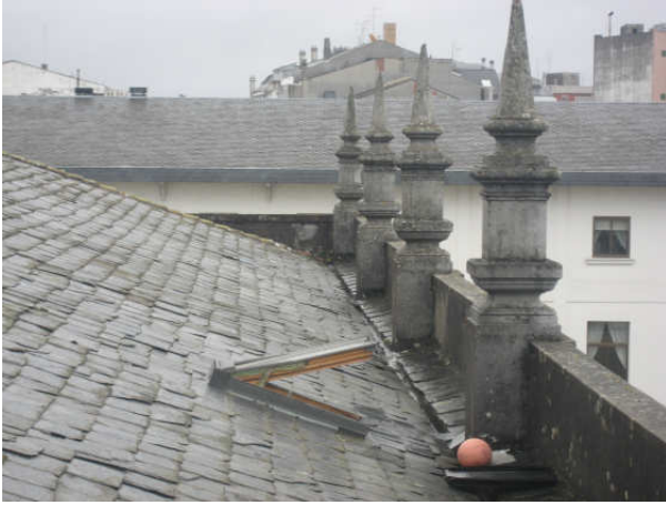
ACCESO A CUBIERTA
