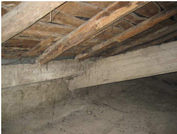
VIGA HACIA FACHADA MEDIANERA OESTE
