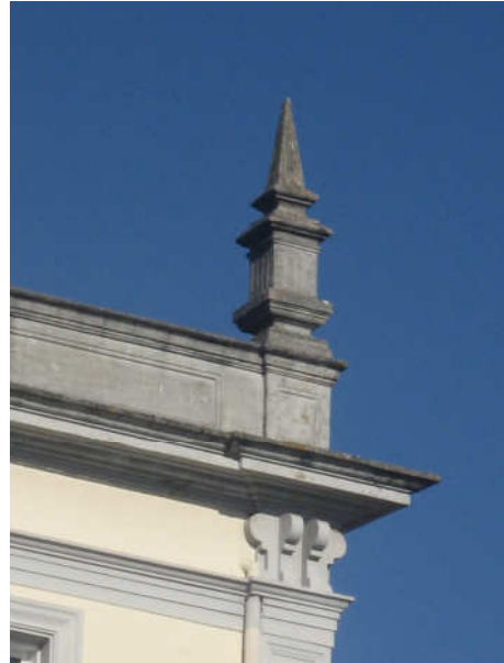
DETALLE DE CORNISA
