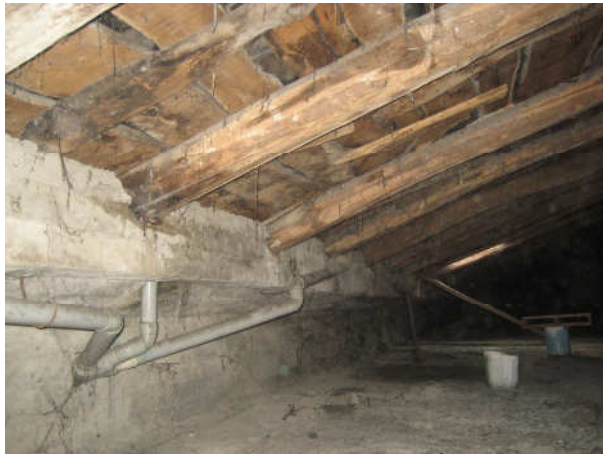
RECOGIDA DE AGUAS EN FALDÓN SUR
