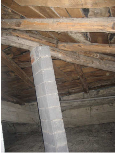
APEO DE VIGA LIMA
