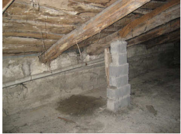
APEO DE VIGA
