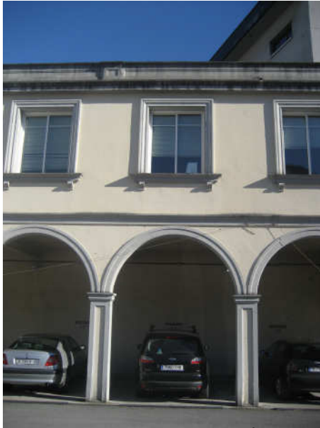
DETALLE DE ARCADAS PABELLÓN ESTE
