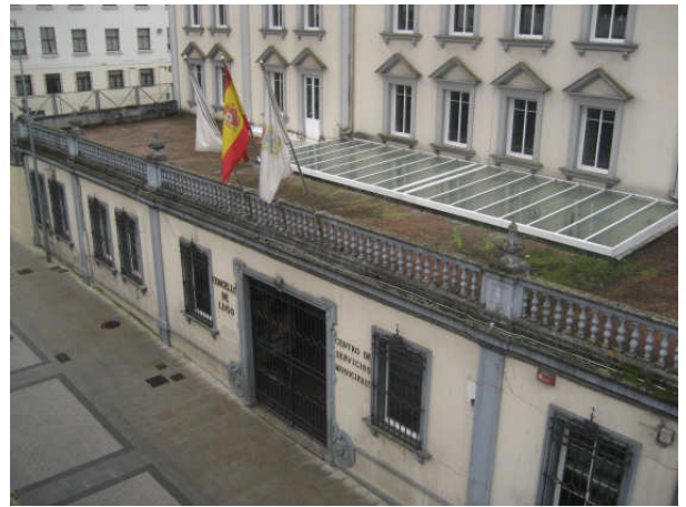
VISTA GENERAL TERRAZA DESDE EL OESTE
