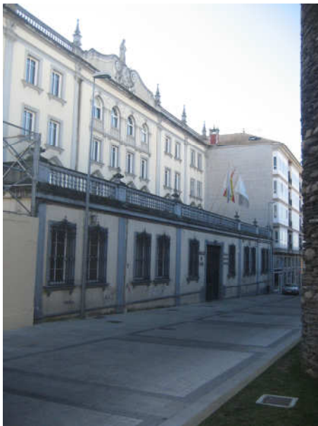
VISTA GENERAL FACHADA NORTE
