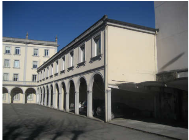
FACHADA PABELLÓN ESTE
