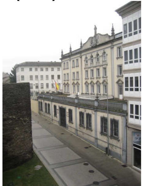
VISTA OESTE DE EDIFICIO MUNICIPAL
