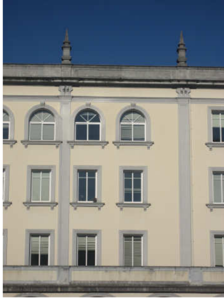
DETALLE DE PARTE CENTRAL DE FACHADA SUR
