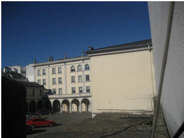
LATERAL PABELLÓN ESTE
