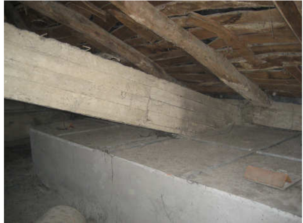
VIGA DE CUBIERTA SOBRE CUERPO DE ASCENSORES
