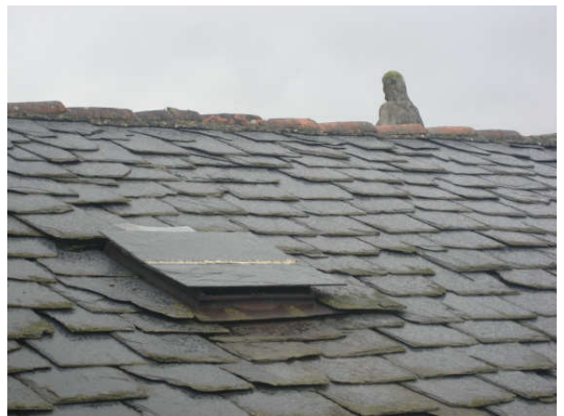
LUCERNARIO DE CUBIERTA
