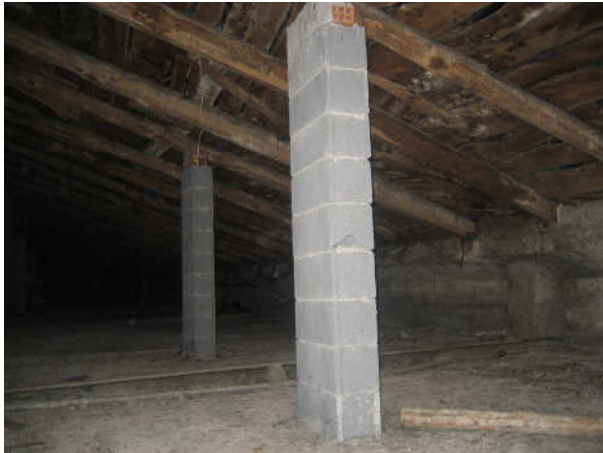
APEOS DE VIGAS DE CUBIERTA
