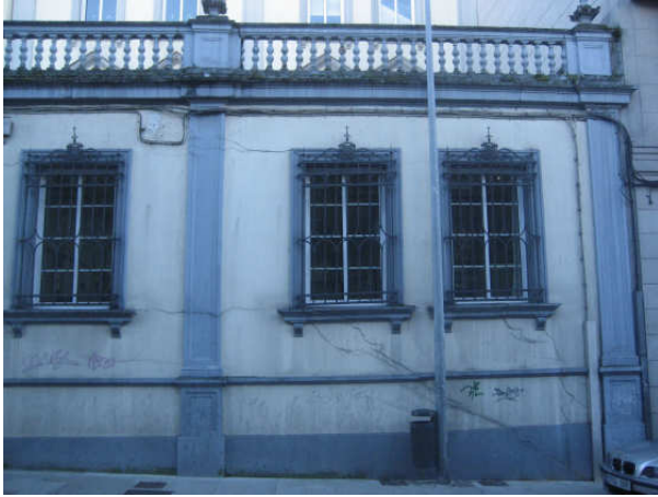
FACHADA NORTE - LADO OESTE
