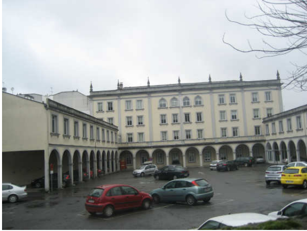
VISTA GENERAL FACHADA
