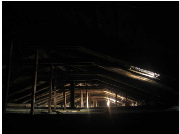
ESPACIO ENTRE FALSO TECHO Y CUBIERTA
