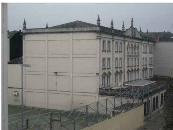
MURO MEDIANERO EDIFICIO MUNICIPAL
