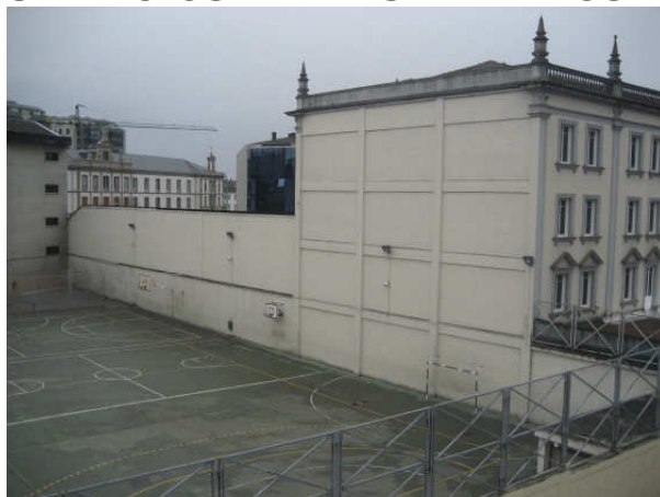
VISTA GENERAL MURO MEDIANERO
