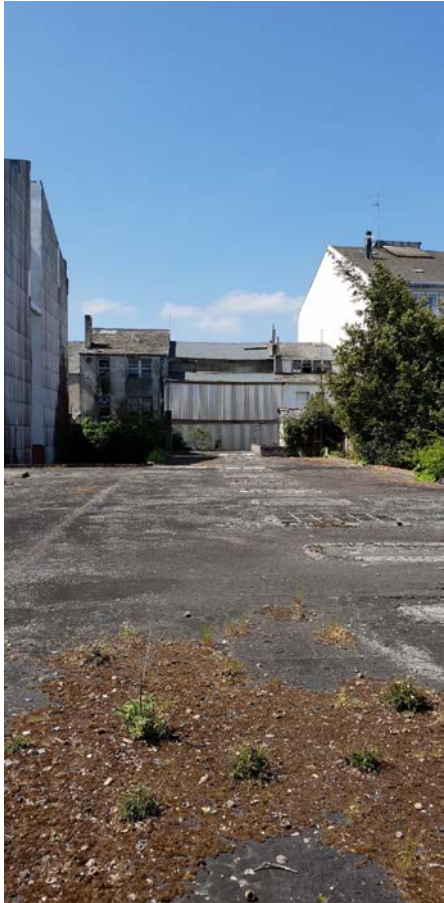
PARTE POSTERIOR AMBAS EDIFICACIONES
