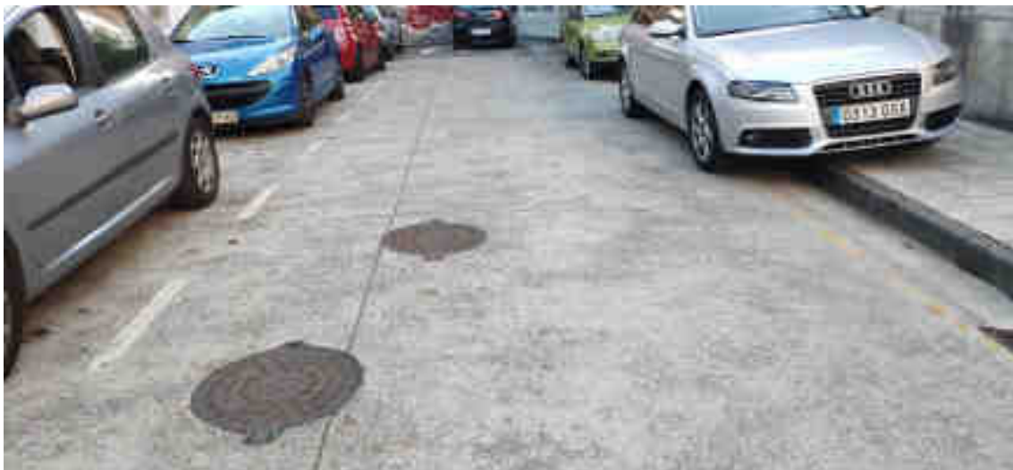
Ilustración 15 Pozos de saneamento de pluviais e fecais na rúa Xacobe III de Inglaterra
