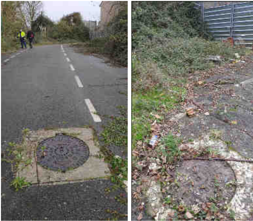
Ilustración 19 Pozos de Pluviais polo centro da calzada do tramo novo da rúa Garañón dentro do ámbito
