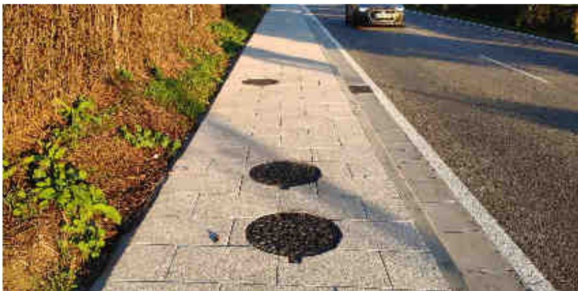
Ilustración 9 Tapas de pozos de fecais e pluviais na rúa República Arxentina
