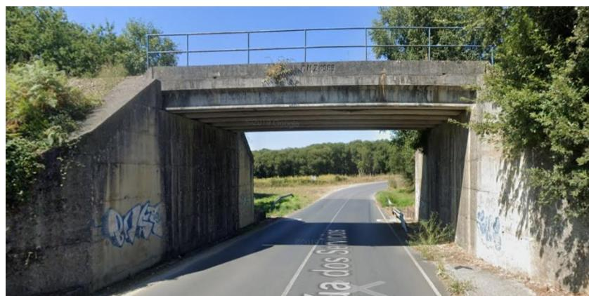
El paso Inferior existente tiene unas dimensiones de 7 metros de largo, 8 metros de ancho y un gálibo de 5,5 metros. Consta de 2 estribos sobre el que se apoyan 6 vigas prefabricadas de hormigón sobre las que se apoya la plataforma de la vía.
