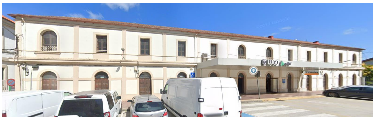
Estación de ferrocarril Lugo
