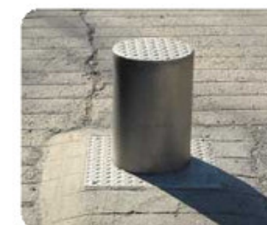
Entrada a una supermanzana por un sistema de bolardos retráctiles
