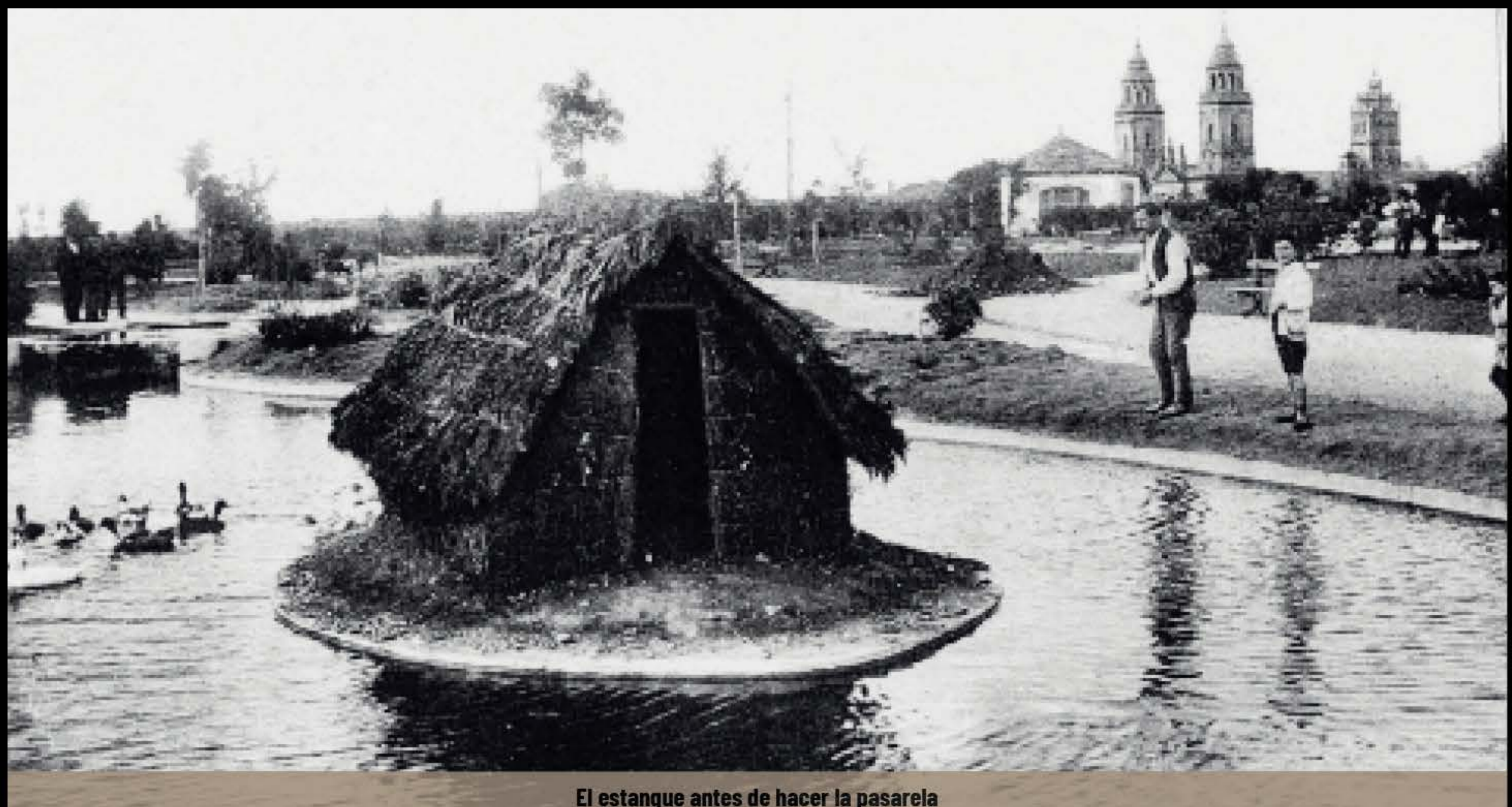
El estanque antes de hacer la pasarela
